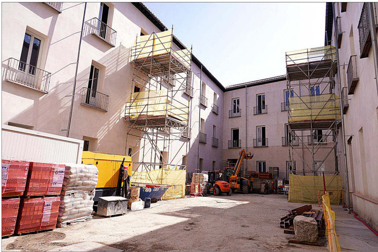
Obras en el patio interior del palacio de la Duquesa de Sueca, que se convertirá en un gran complejo social. AYTO. DE MADRID
