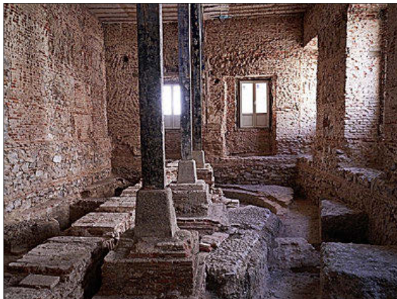
Interior del inmueble tras las obras de rehabilitación. A. MADRID
